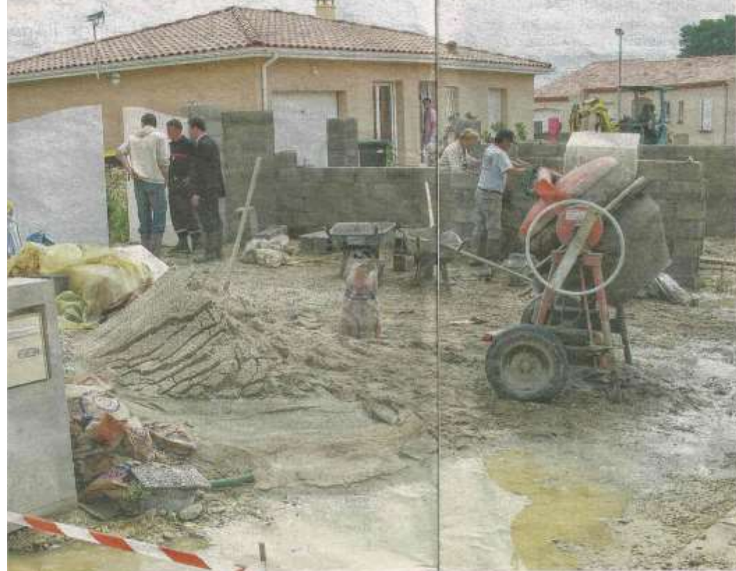
nt été touchées par d'importantes inondations. plus de dégâts, avec des maisons ravagées SUD OUEST
