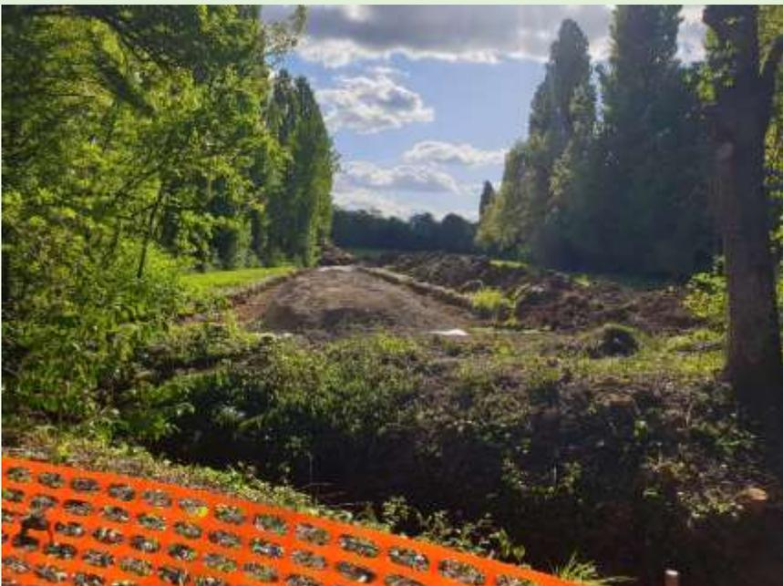
1) Construction d'un pont éphémère et d'une dérivation de la route de Samazan
